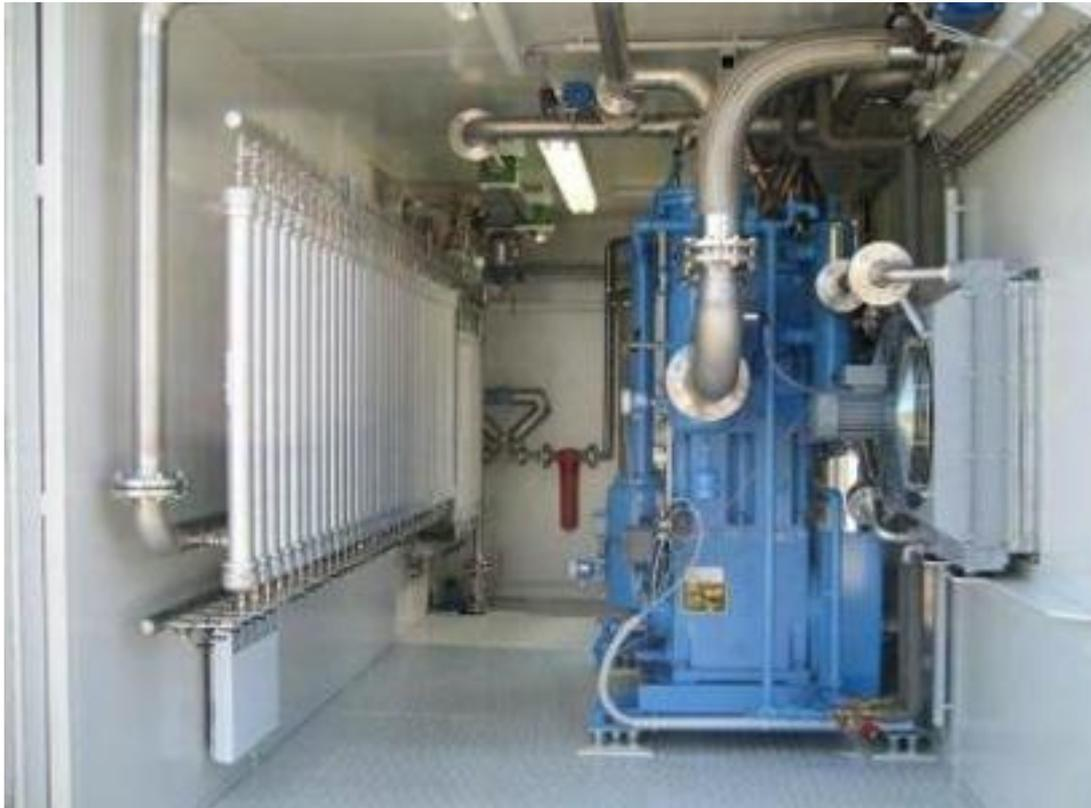
Interior de uma planta de purificação de biogás por membranas.
