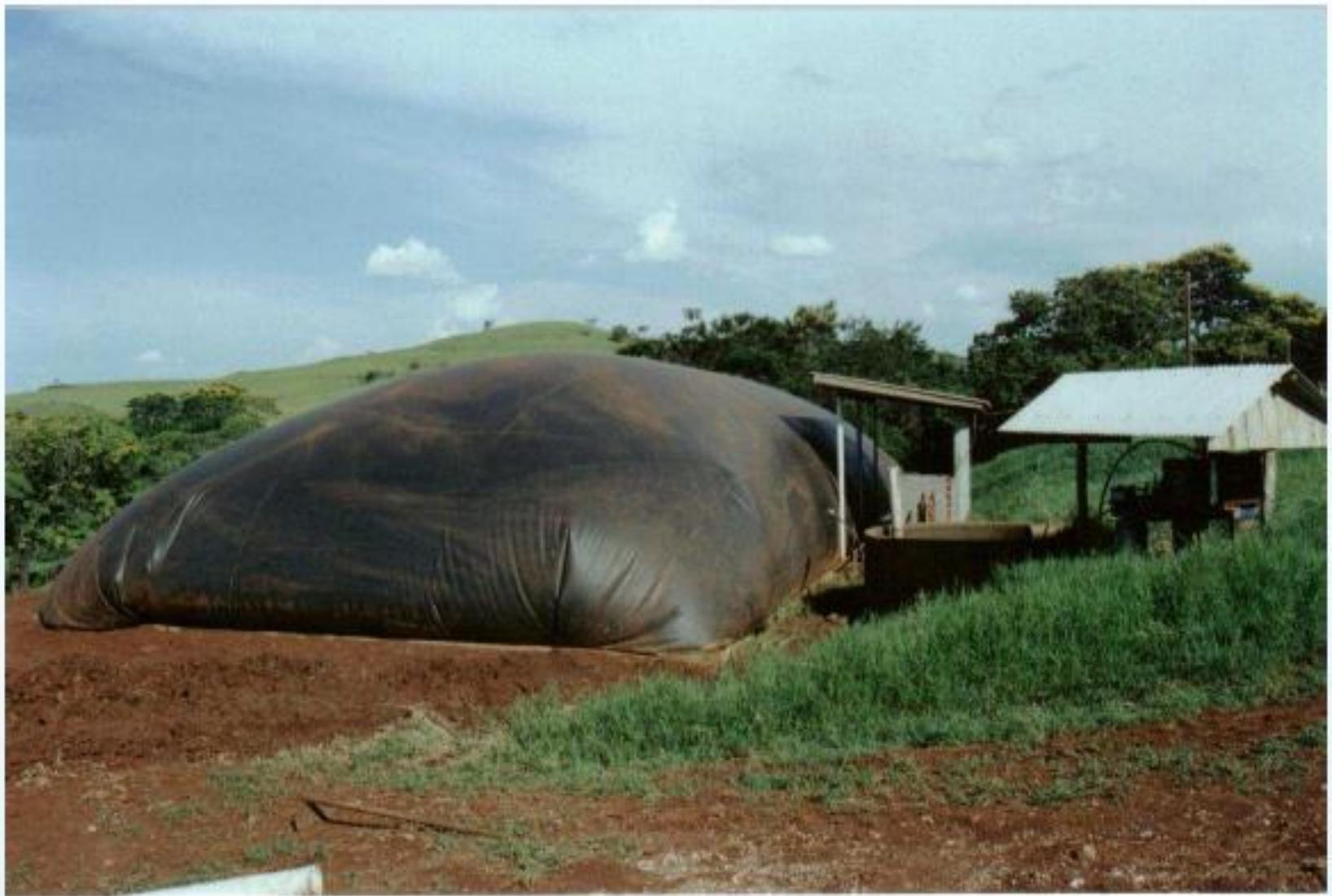
Figura 10: Biodigestor Tubular utilizando dejetos de Bovinos — Fazenda Modelo, em Engenheiro Beltrão-PR.
