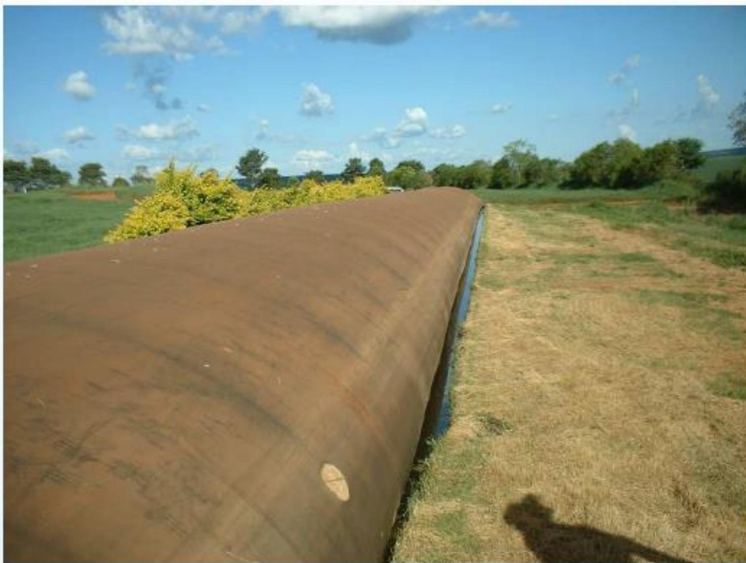
Figura 7: Biodigestor Tubular utilizando dejetos de Bovinos de Leite
