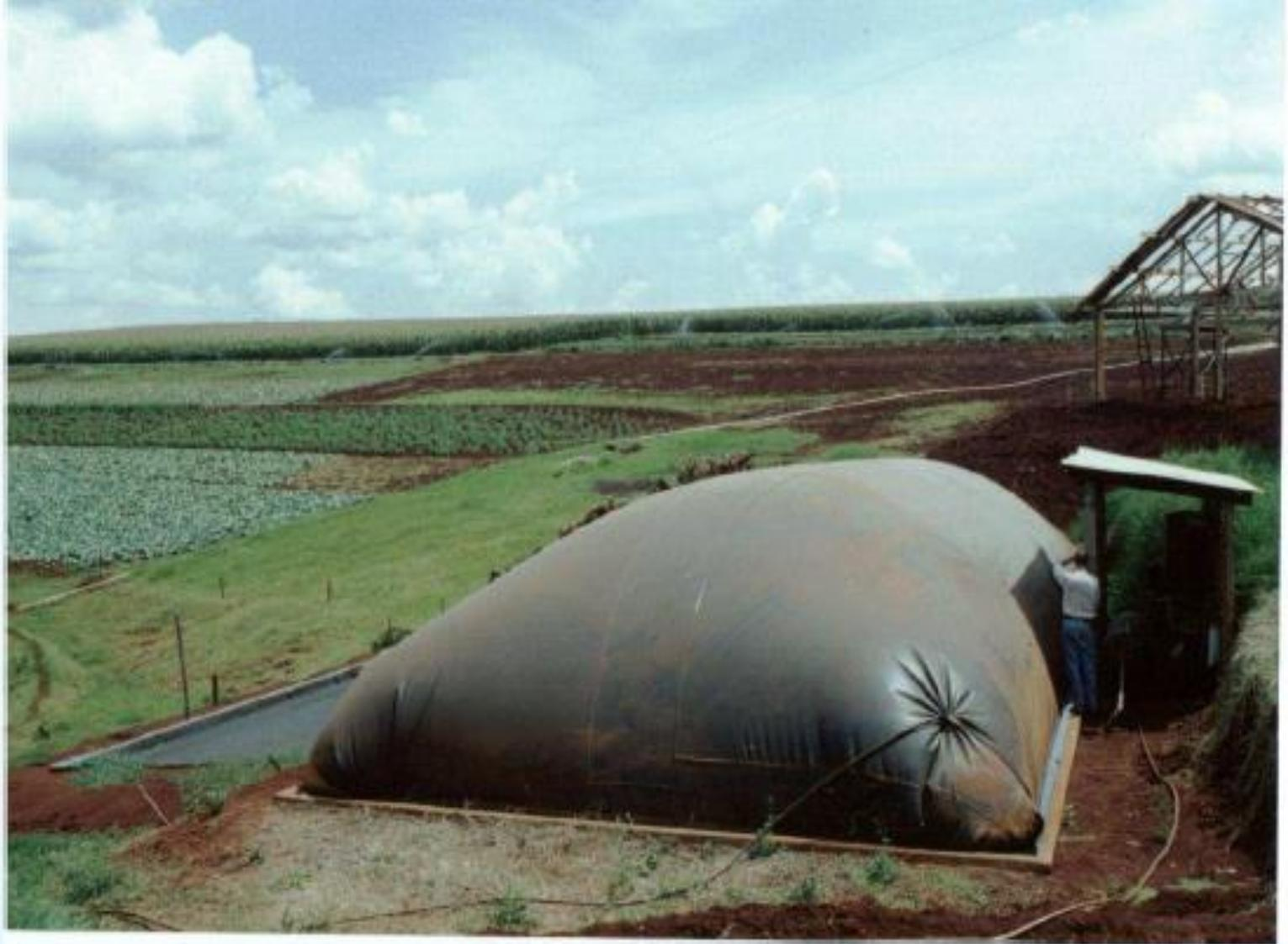
Figura 11: Biodigestor Tubular utilizando dejetos de Suínos — Fazenda Pontim, em Engenheiro Beltrão-PR.
