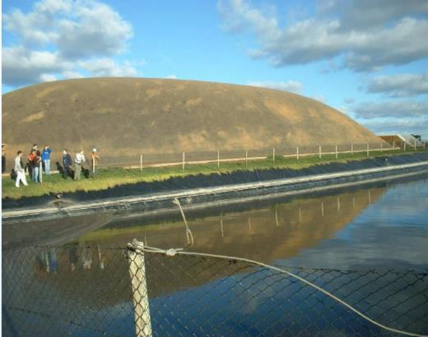
Figura 13: Biodigestor Tubular utilizando dejetos de Bovinos de Leite — Fazenda Frankana, em Ponta Grossa-PR.
