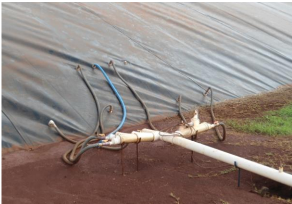
Flanges de captação do biogás
