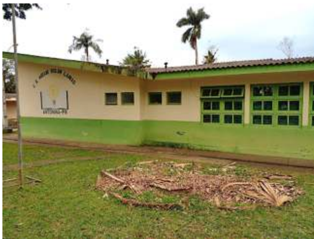
FIGURA 3 - Fachada do Colégio
